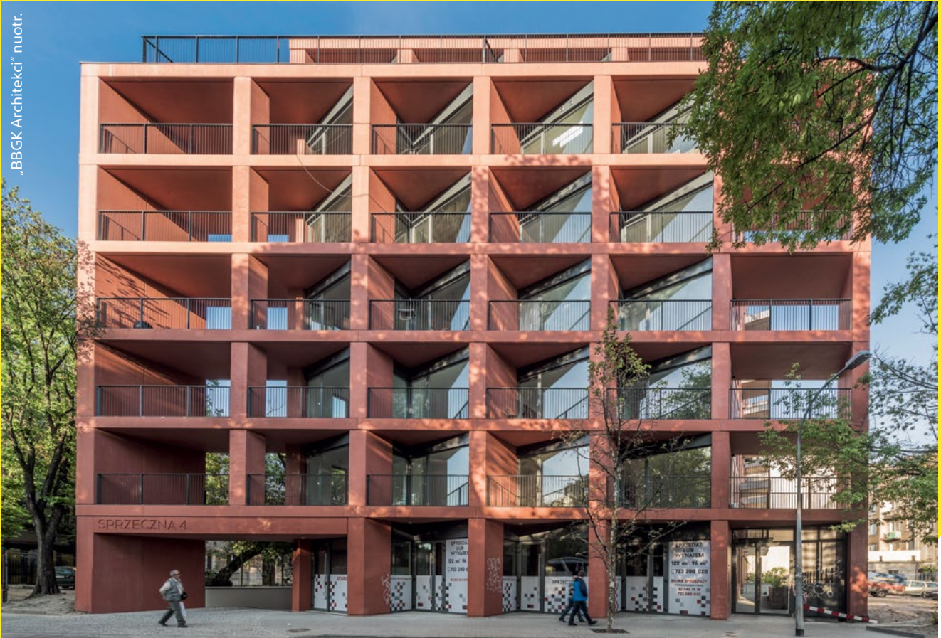
Architektų studijos „BBGK Architektci” supro- jektuotas daugiabutis.
